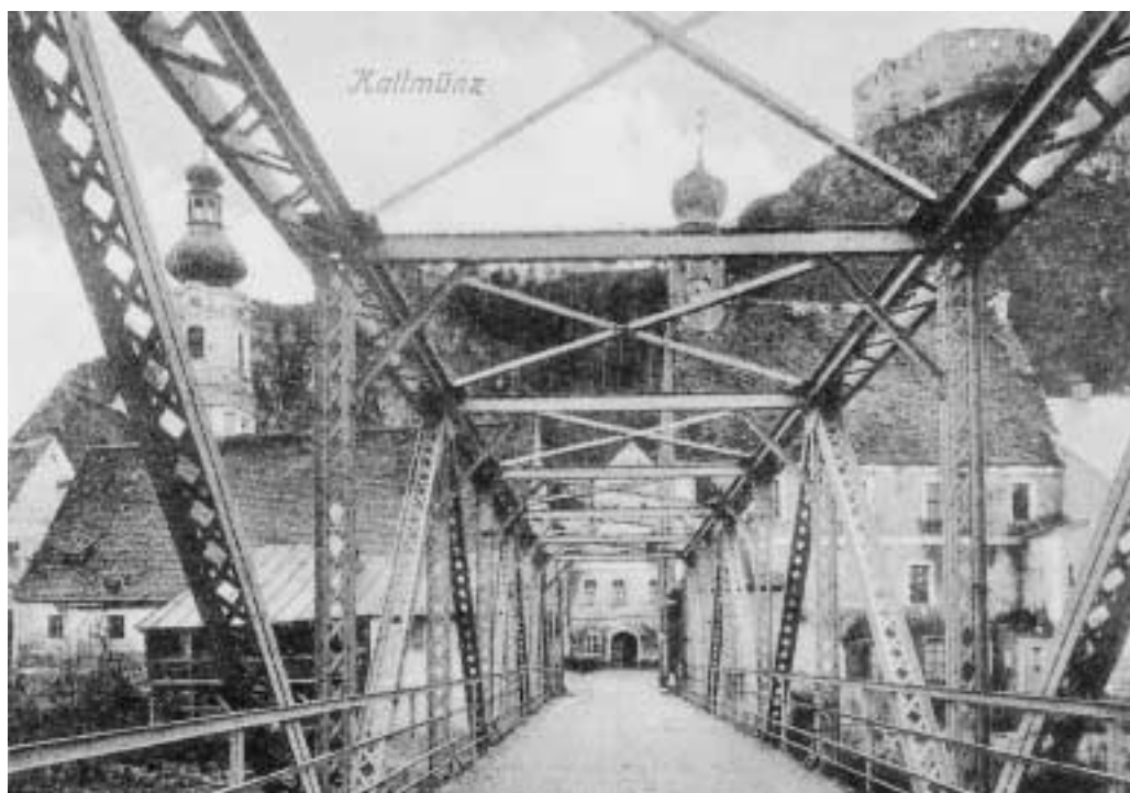
Das ewige Provisorium unserer Naabbrücke. Dieser Teil wurde vor Jahrhunderten durch einen Eisstoß zerstört. So sah die Brücke von den 1890er Jahren bis zur Sprengung 1945 aus.
